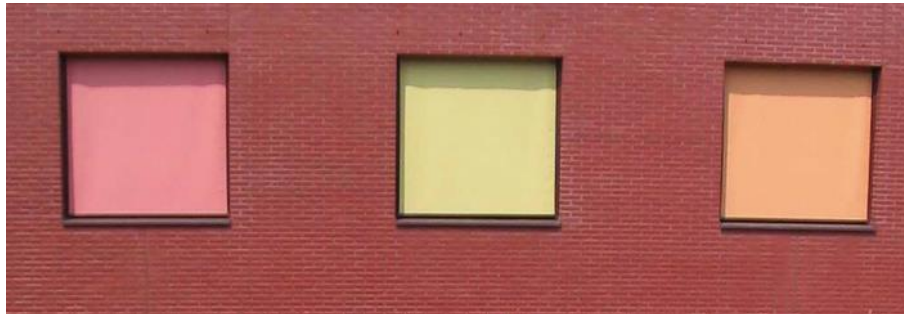
Afbeelding 3.11 Passieve klimaatbeheersing door zonwering
