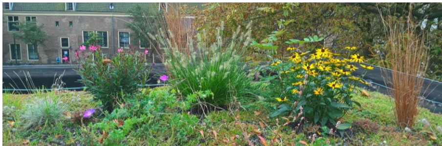
Afbeelding 3.13 Een intensief groen dak draagt bij aan verkoeling, waterberging, biodiversiteit, bescherming van dakbedekking en hoger rendement van zonnepanelen
